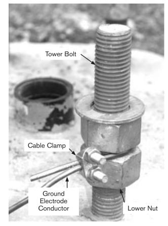
Fig. 3 Tower foundation bolt.
