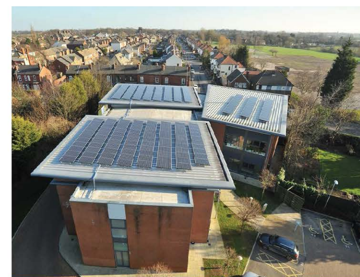
45kWp PV Array
